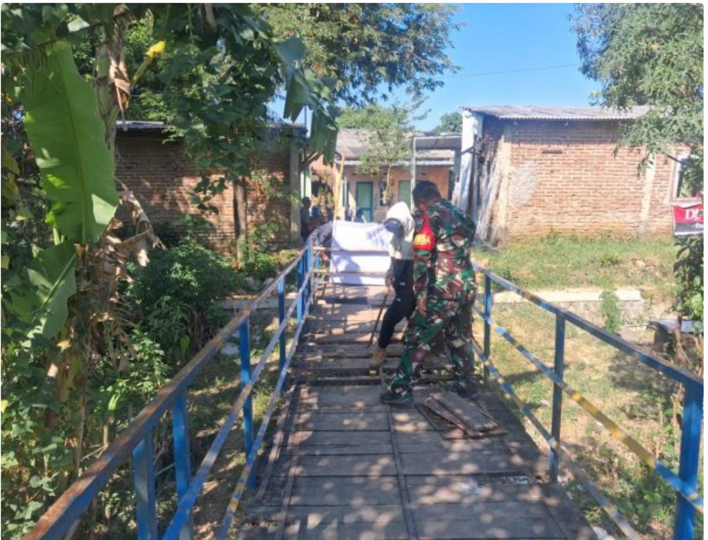
Perbaikan jembatan Gantung Kel. Kecapi Kota Cirebon
